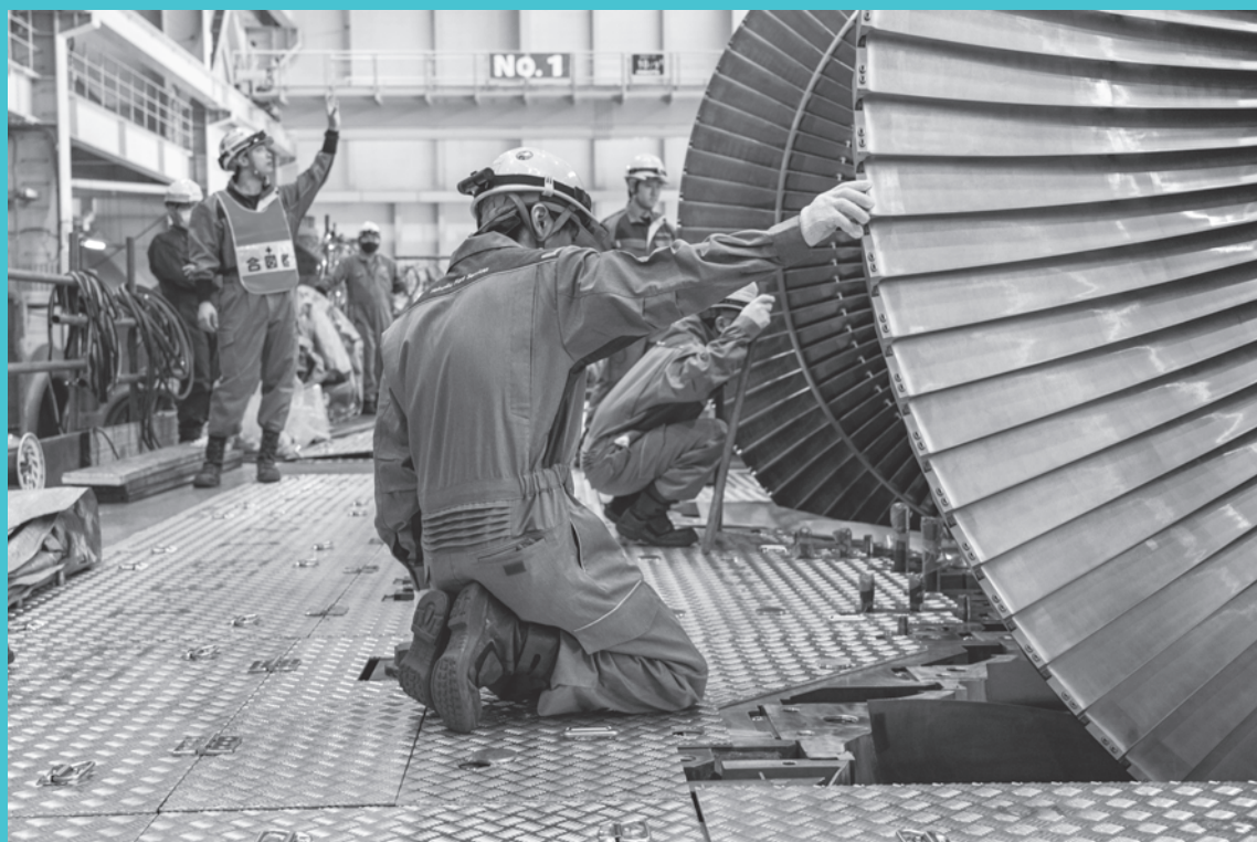
大型蒸気タービン点検作業 写真提供:北陸プラントサービス株式会社
