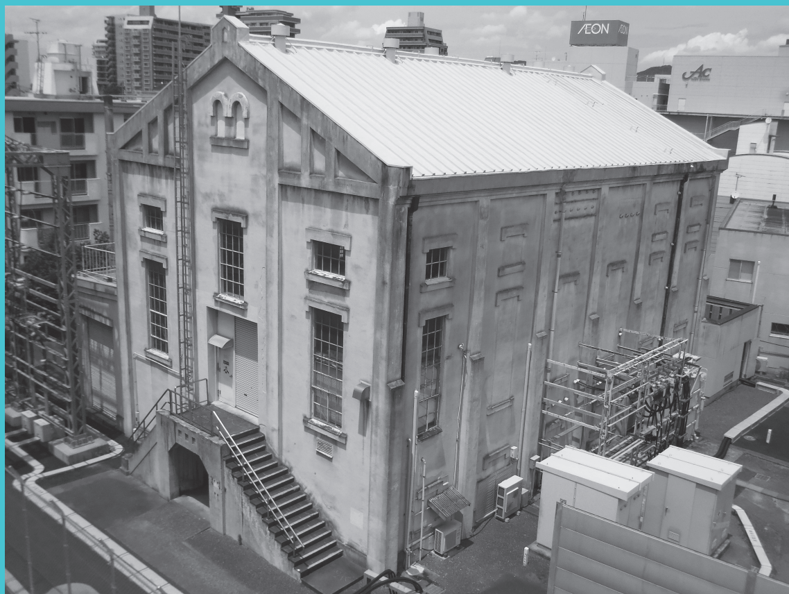
西鉄電車に電気供給100年の春日原変電所 写真提供:西日本鉄道株式会社
