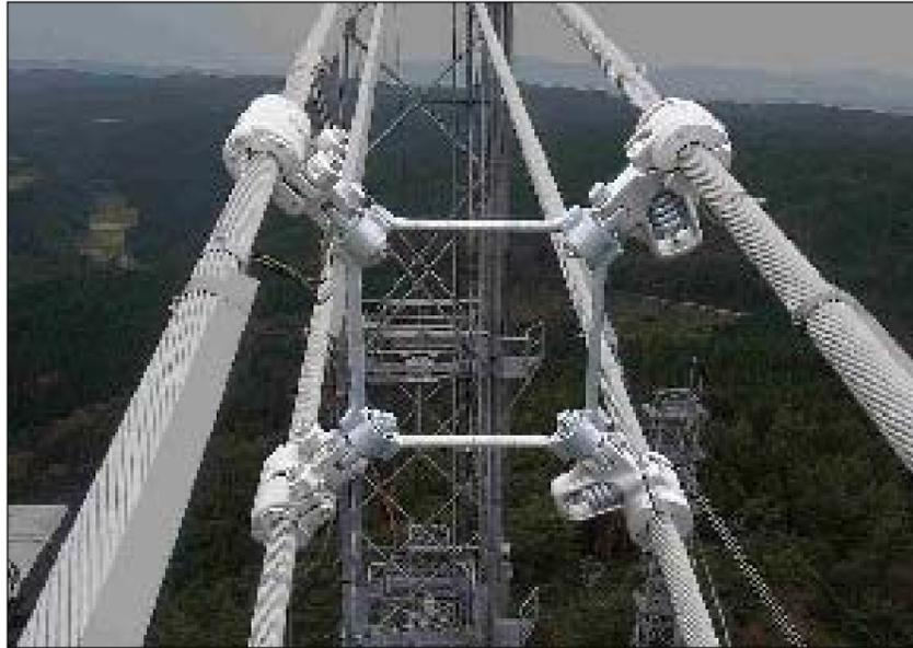
写真の左側電線保持部が自由に可動することにより、揚力特性が変化し、ギャロッピングを抑制する。
